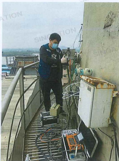
锅炉废气排放口 (FQ-Q5521)
