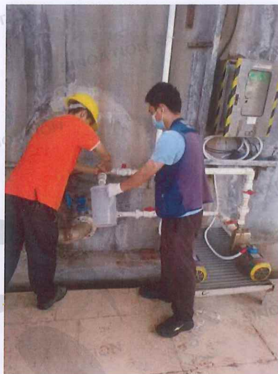
脱硫废水取水点
