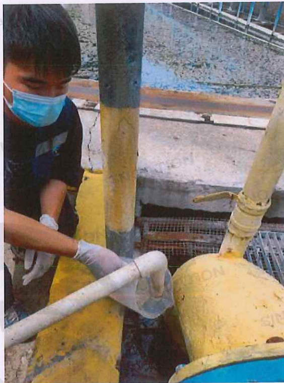
脱硫废水取水点
