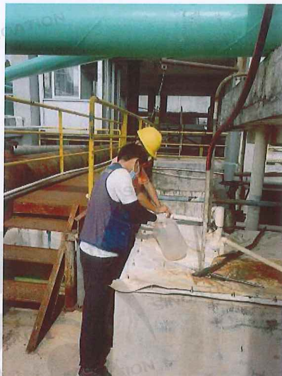
脱硫废水取水点
