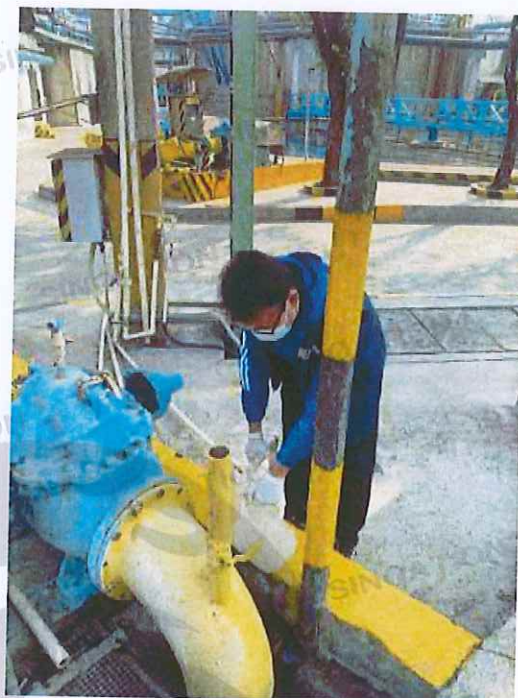
脱硫废水取水点
