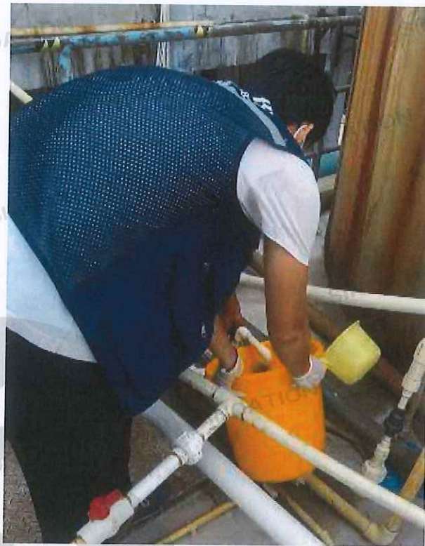
脱硫废水取水点
