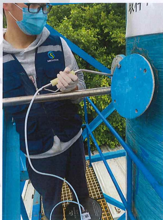
恶臭废气排放口 2#
